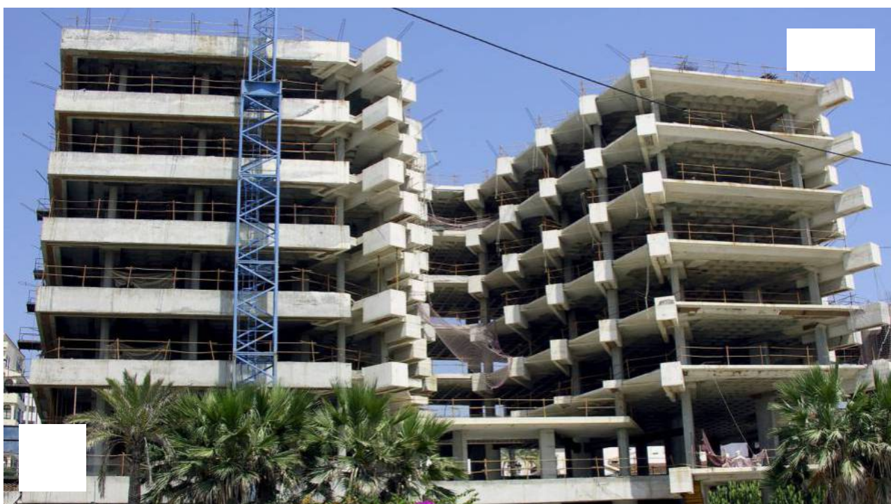
Viviendas en construcción en Estepona (Málaga)/EFE / ATLAS
